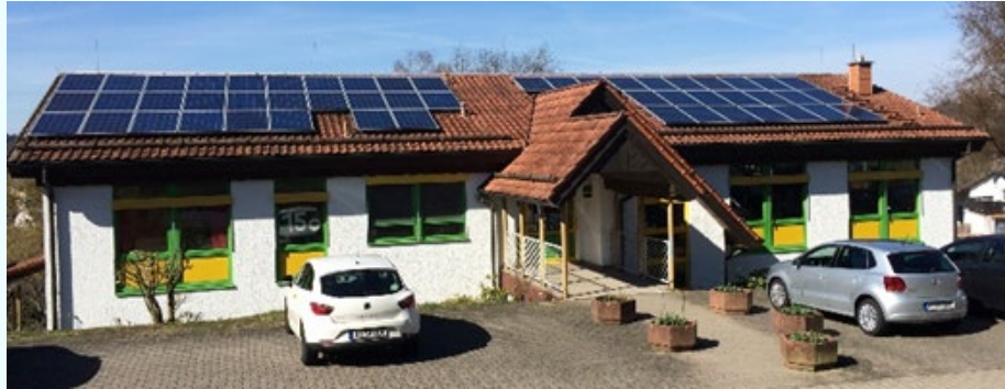
Abbildung 2-20: PV-Anlage auf dem katholischen Kindergarten
