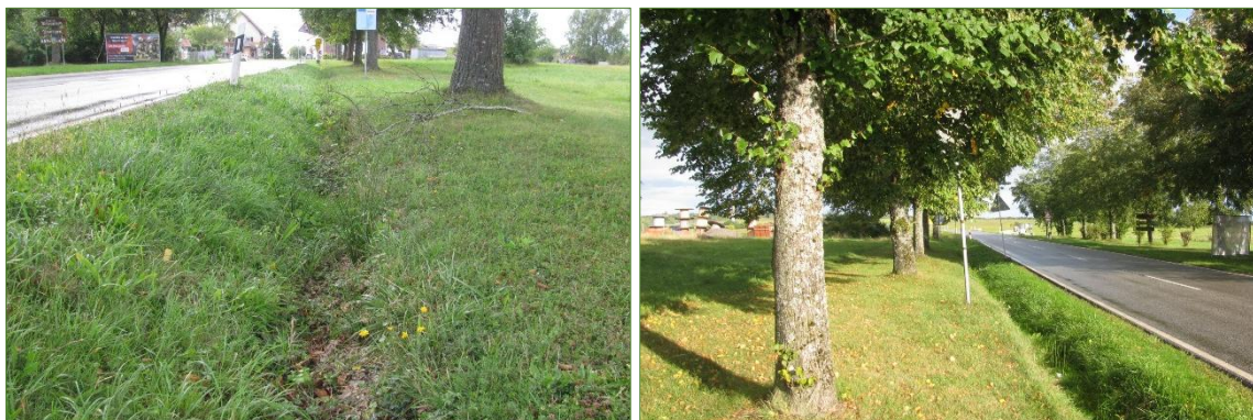
Abbildung 23 und 24: Entwässerungsmulde entlang der Landesstraße (Quelle: ARGUS CONCEPT GmbH)
