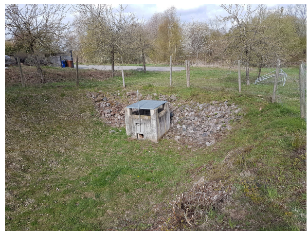
Bilder 4 und 5: Rückhaltemulden und Entlastungsbauwerk (Mönch)
