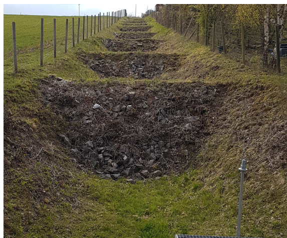
Bilder 4 und 5: Rückhaltemulden und Entlastungsbauwerk (Mönch)
